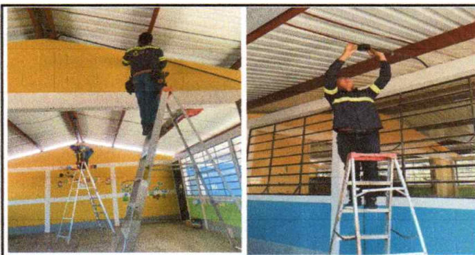
Foto 6: CAMBIÓ DE LÁMPARAS Y SISTEMA ELÉCTRICO
