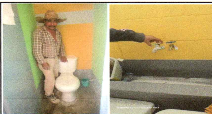
Foto 5: CAMBIÓ DE SANITARIOS Y SUS ACCESORIOS, CAMBIO DE CHORROS
