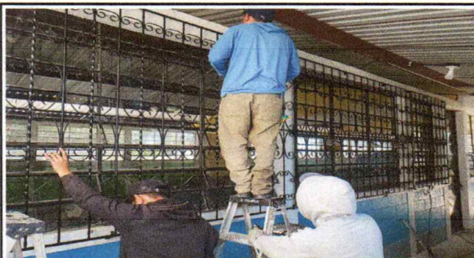
Foto 3: COLOCACIÓN DE VALCONES EN VENTANAS EXPUESTAS
